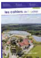
Page de garde : La ferme solaire de Sévignacq Mise en service en mars 2014, c'est la plus grande ferme solaire du département (plus de 17 000 panneaux photovoltaïques). Elle alimente le centre de tri des déchets ménagers tout en amenant des revenus à la communauté de communes.
