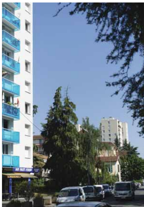
Une réhabilitation récente, avenue du Loup
