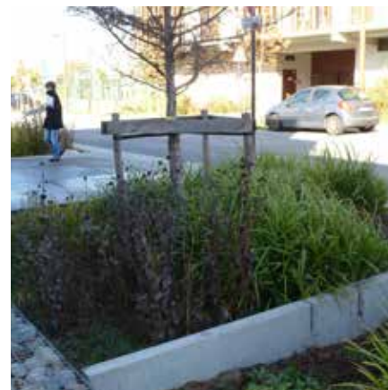
Rues accueillant des noues qui réduisent le ruissellement et limitent le débit de fuite du quartier vers l'Hers, exutoire naturel du site
