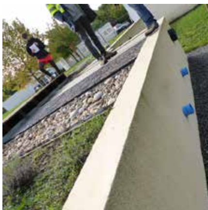
La diversité des tranchées drainantes permet un bon écrêtement des débits de pointe et du stockage temporaire des eaux de ruissellement
