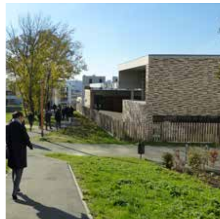
Eco-quartier Vidailhan : différentes structures de rétention selon statut des espaces ; ici infiltration le long des cheminements piétons enherbés
