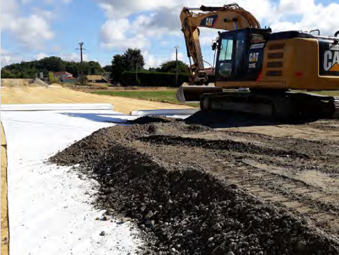
Mise en place de graves recyclées sur le chantier du Département 64 de Serres-Castet – octobre 2018 Crédit Photo Département 64
