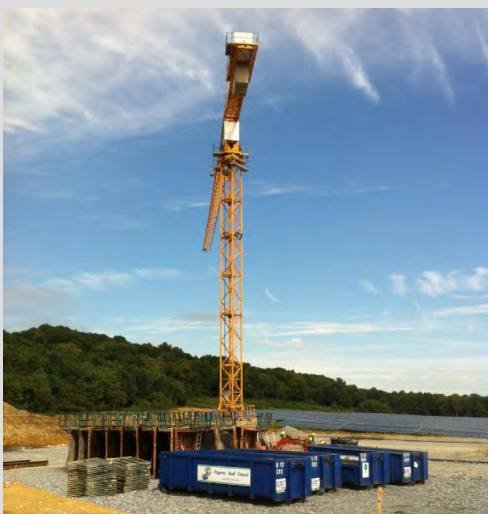
Tri sélectif des déchets sur la base vie - Source Indiggo
