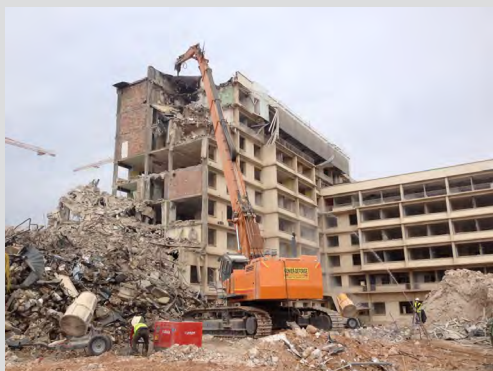
Déconstruction de l'hôpital Font-Pré à Toulon- Source Photo Premys (filière Colas) - Agence Genier-Deforge Méditerranée
