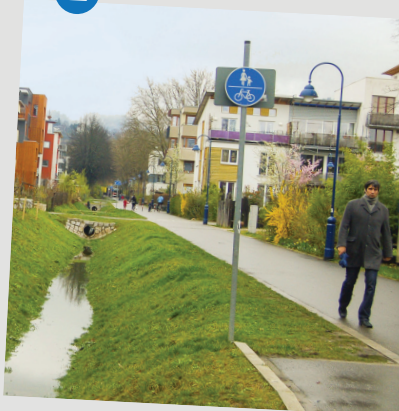
Fossé en eau et chaussée drainante Quartier Vauban à Fribourg (Allemagne)
