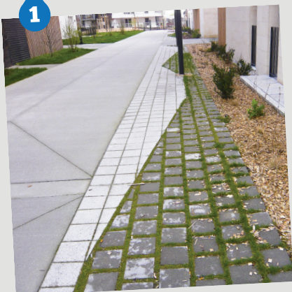
Pavés non jointés et tranchée d'infiltration Projet Ginko à Bordeaux (33)
