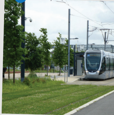
Chaussée de tramway à structure réservoir Quartier Andromède à Toulouse (31)
