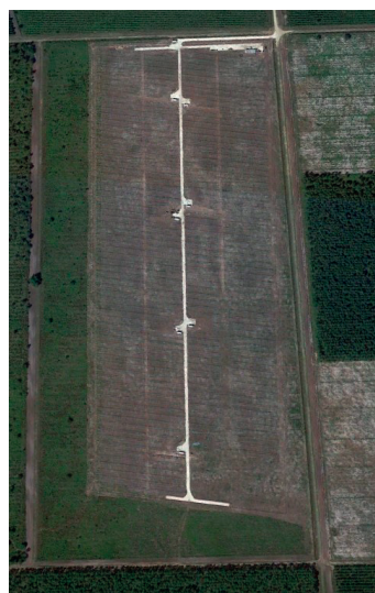
Parc solaire à Mios (Gironde), phase chantier, juillet 2017 : seule la zone clôturée de 19 ha est remaniée © Google Earth
