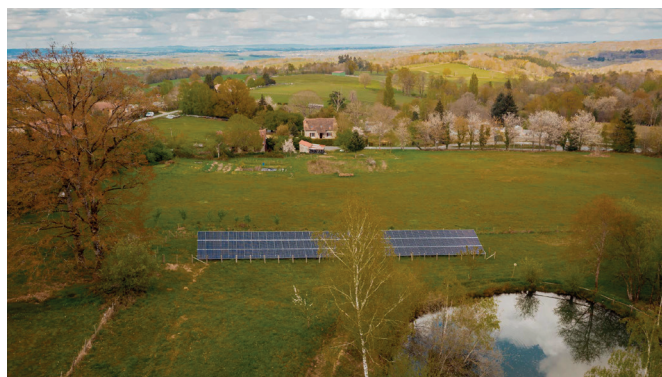
Une des cinq centrales solaires de la commune de Rilhac-Lastours © Lycia Walter - Enercoop Nouvelle-Aquitaine
