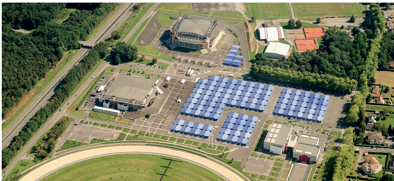
Ombrières implantées sur le parking du Zénith de Pau (64) © Neoen
