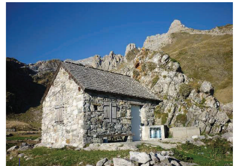
Cuyalas de Lagne et prairies d'estives en montagne béarnaise Source photo : pyrenees-refuges
