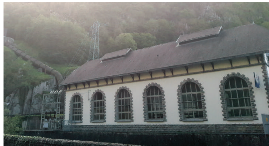
Centrale hydroélectrique d'Accous - Vallée d'Aspe Source photo : Audap
