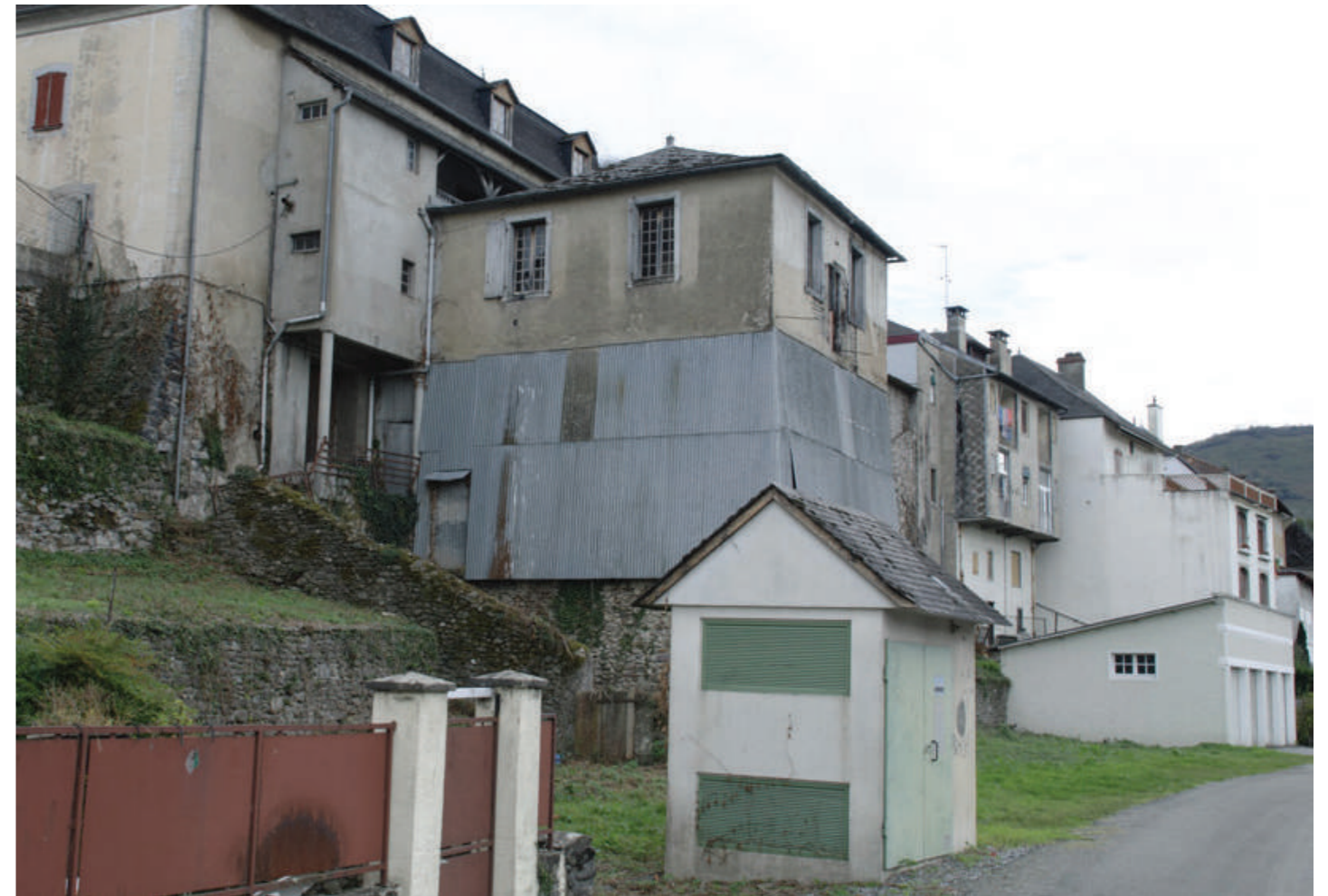
Logements vacants - Tardets Source photo : Audap
