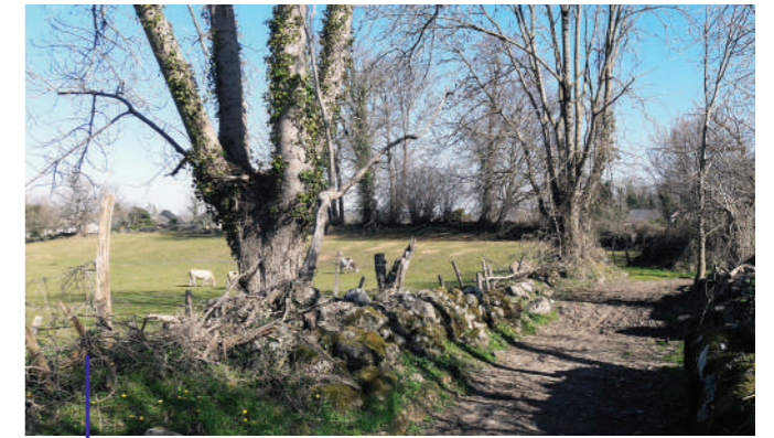
Muret en pierre à l'abandon - Buzy, Piémont Oloronais - Source photo : Audap
