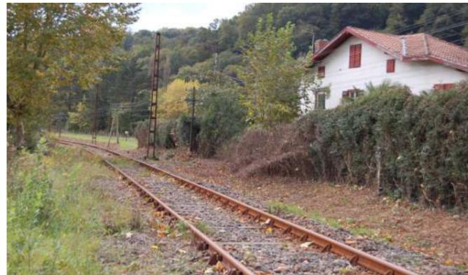
La ligne à voie unique à hauteur de Bidarray : une section de ligne de Cambo à Garazi soumise à de nombreuses limitations de vitesse liées à la vétusté de la voie : l'enjeu du projet de modernisation de cette nouvelle section de ligne
