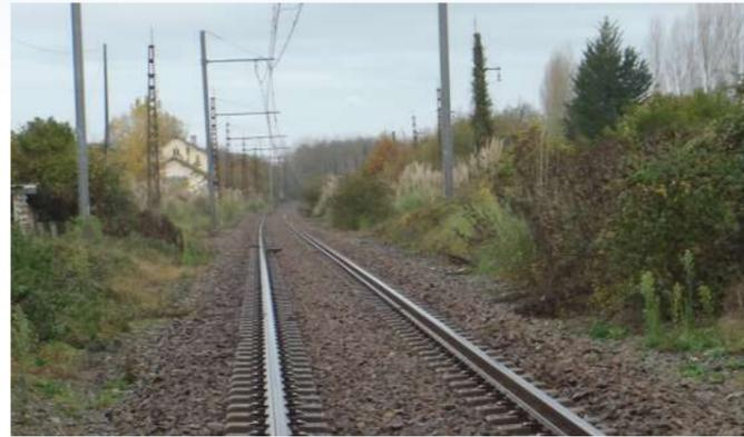
L'axe ferré Adour : une ligne en voie unique électrifiée sans système de signalisation automatique réduisant les capacités de circulation malgré tout l'intérêt de la ligne pour les liaisons au sein d'un réseau de villes du piémont des Pyrénées Atlantiques (de Bayonne, Peyrehorade, Orthez, Pau).
